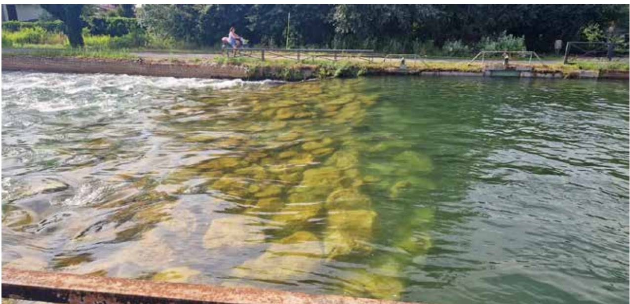
Sbarramenti alveo del Naviglio.
